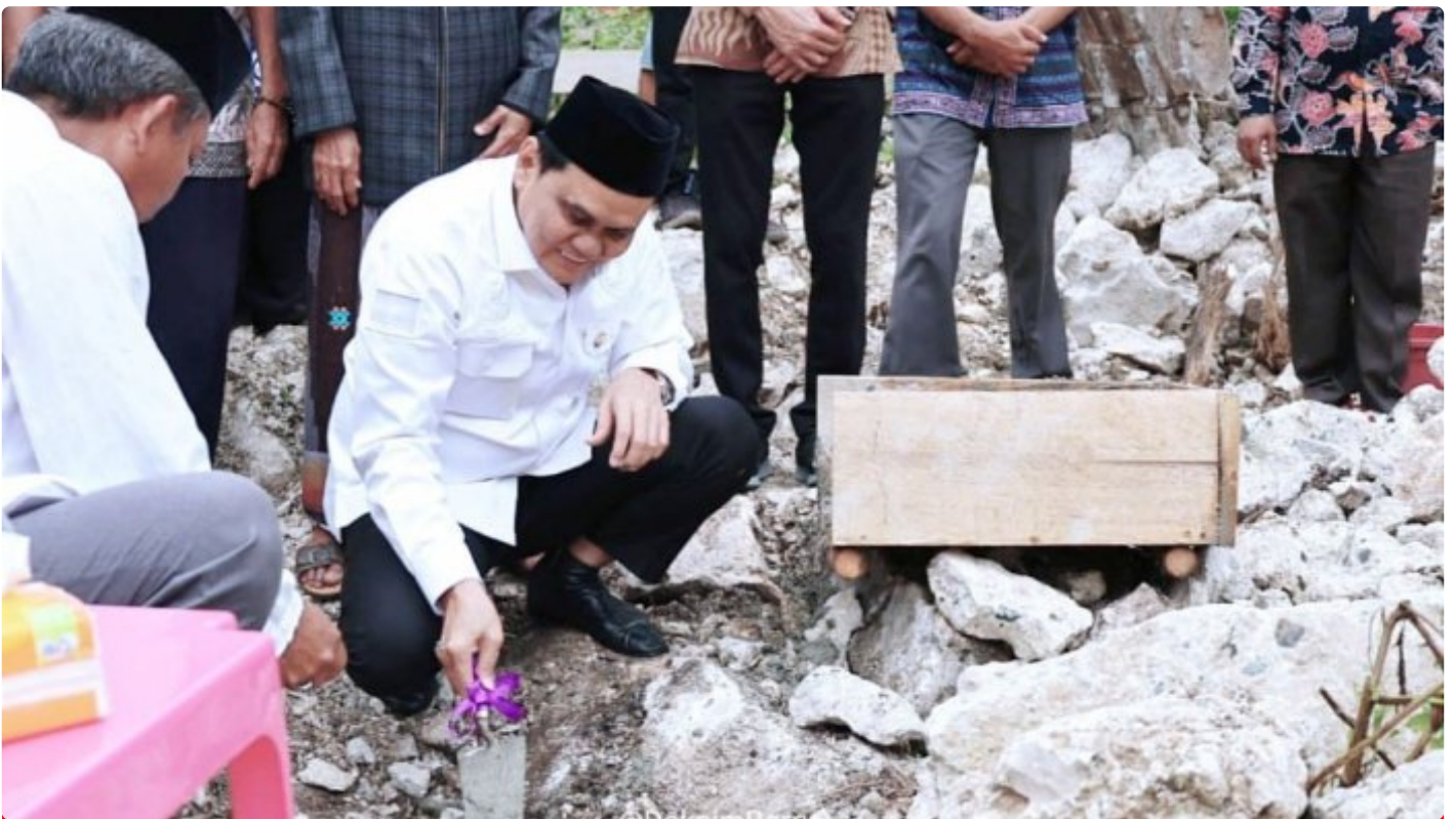
Kegiatan peletakan batu pertama Mushollah Al Barru di Dusun Pange, Desa Palakka, Kecamatan Barru
